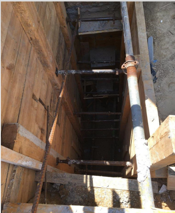
Dreistufige Fundamentunterfangung
